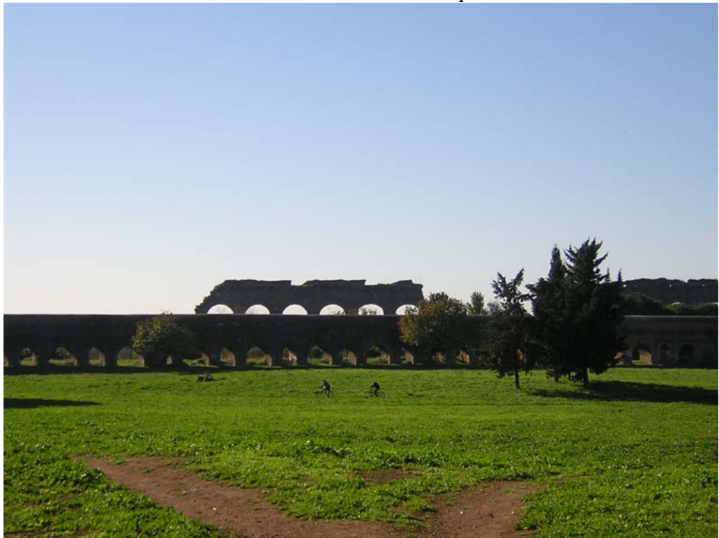
Figura 2 Roma - parco degli acquedotti: l'Acquedotto Felice (medioevale) Sovrastato dagli imponenti archi dell'Acquedotto Claudio (52 d.C.) (archivio G.Temporelli)
